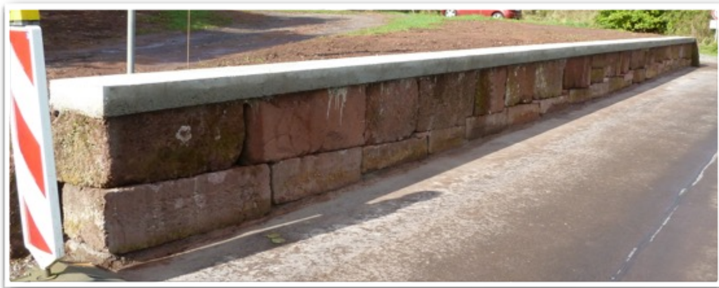
Die neue Mauer im Bereich des Parkplatzes.
