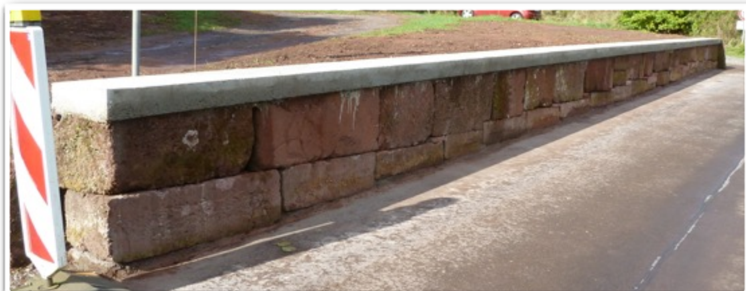
Die neue Mauer im Bereich des Parkplatzes.
